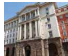
Снимка в. „Строител“
