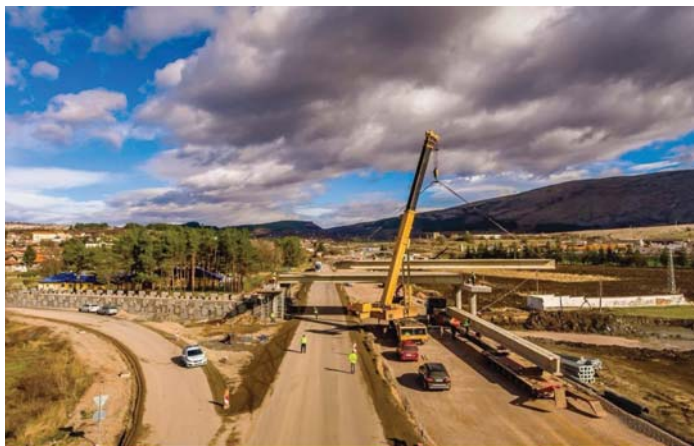
Строителството на АМ „Европа“
