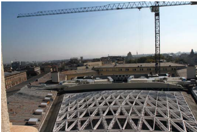
Строителството на новата пленарна зала на парламента
